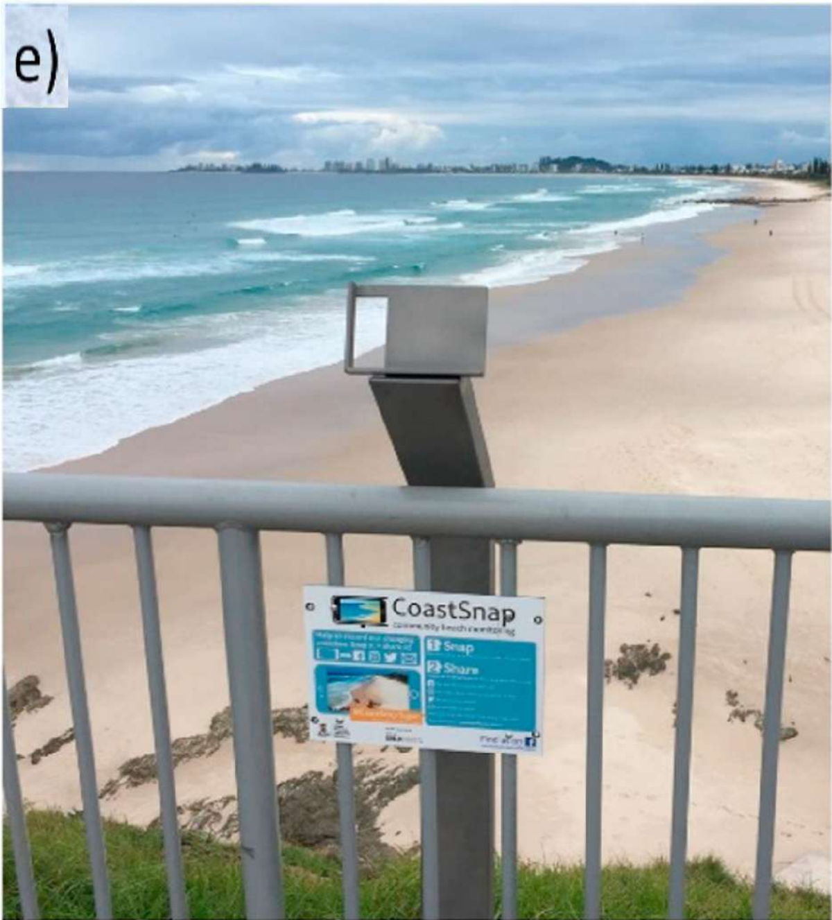
Figura 11 - Tipologia di stazione "E" - Supporto per smartphone installato impernato su parapetto in acciaio già esistente, in questo caso il banner sul funzionamento del sistema CoastSNAP, su supporto rigido, è stato impernato anch'esso al parapetto.
