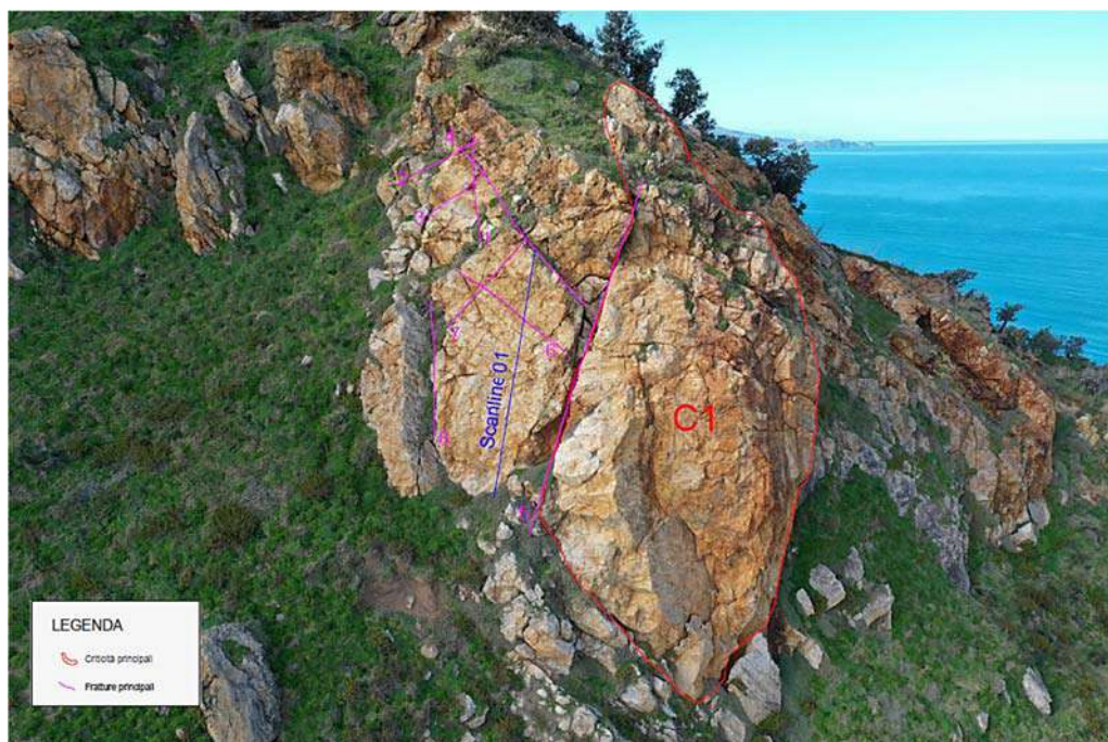
Figura 8 – Tavola 2 delle fratture e criticità principali rilevate in sito
